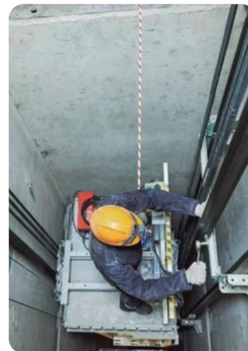
• Línea de seguridad vertical portátil, en cuerda de poliamida de alta tenacidad termofijada tipo A de 120 mm con guarda cabos de PVC en extremos, EN 1891 y bloqueador automático desmontable con seguro más absorbedor de energía. **CE EN 353-2**
