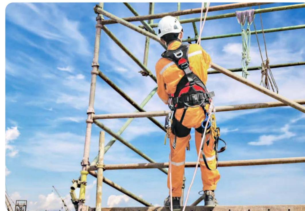
• Punto de anclaje lazo. Fabricado en poliéster de alta tenacidad de 50 mm de ancho (PES). Con anilla metálica y asa reforzada. Rotura mínima 25 kN. **CE EN 795 clase B**
